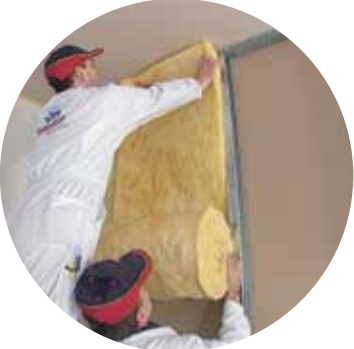
Slika 3: Izolacijo vstavimo v enem kosu
