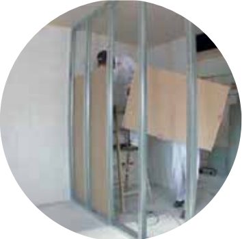
Slika 2: Namestimo prvi sloj mavčnokartonskih plošč
