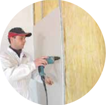
Slika 6: Steno zaključimo z oblogo iz mavčno kartonske plošče
