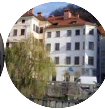
Primer objekta po prenavi. Vir gradiva: GIVO, d.o.o., Ljubljana
