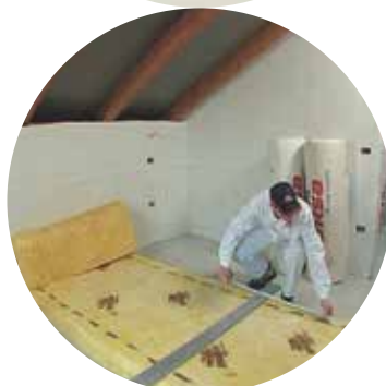
Slika 4: Izolacijo razrežemo na primerno velike plošče
