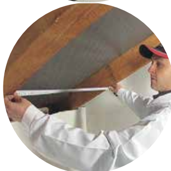
Slika 2: Predhodno položena paroprepustna folija - sekundarna kritina
