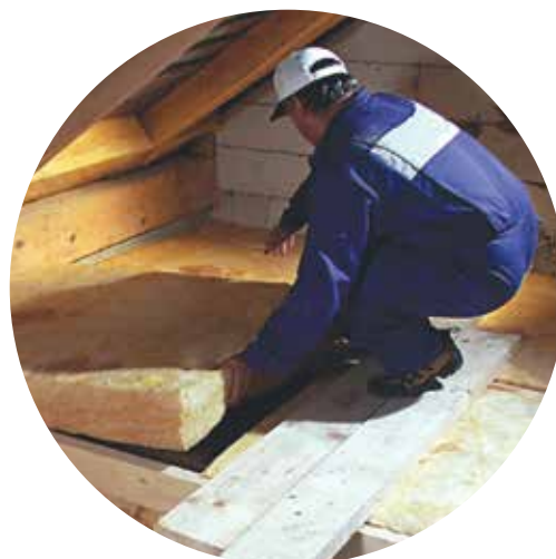
2. Polaganje drugega sloja - pri razrezu izolacije v plošče dodajte 10 % nadmere
