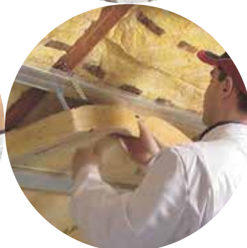
Slika 6: Pod kovinski C-profil vstavimo drugi sloj izolacije
