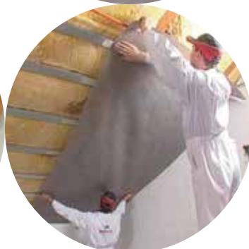
Slika 7: Na C-profil pritrdimo parno oviro z dvostranskim lepilnim trakom
