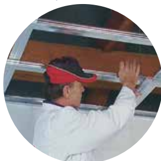
1. Postavimo kovinsko konstrukcijo
