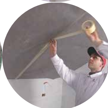
Slika 8: Vse spoje, preboje in priključke na foliji moramo zalepiti
