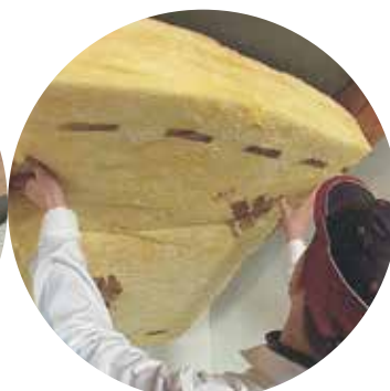
Slika 5: Izolacijo vstavimo med špirovce
