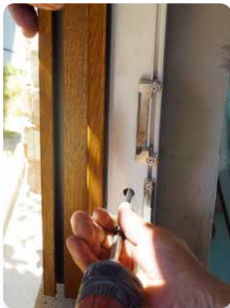
Mehanska pritrditev okna
