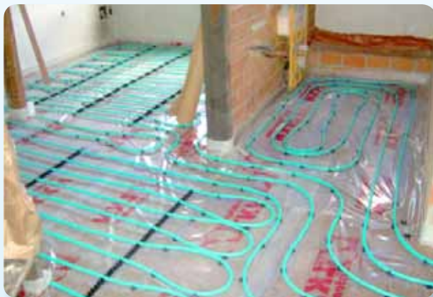
Prikaz izvedbe ploskovnega talnega ogrevanja
