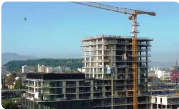
Gradnja nove stavbe v Ljubljani
