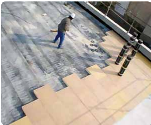
Primer izvedbe toplotne izolacije na ravni strehi
